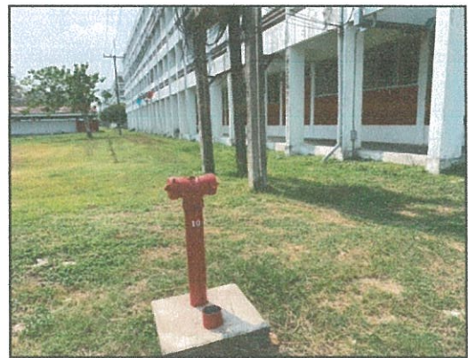
จุดที่ ๑๐ ด้านหลังอาคารกองร้อย ๓
