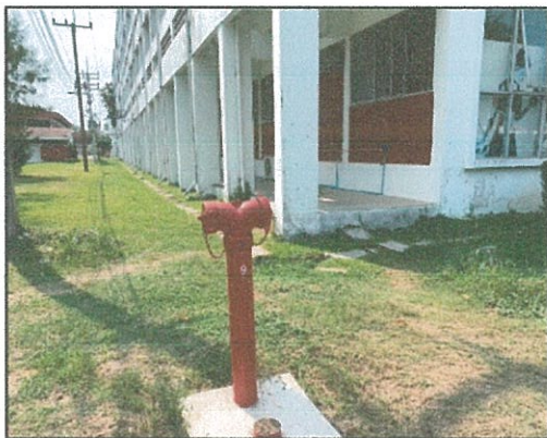
จุดที่ ๙ ด้านหลังอาคารกองร้อย ๕
