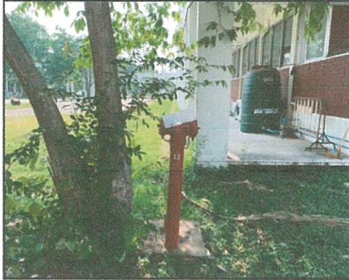
จุดที่ ๑๓ ด้านหลังอาคาร ๕๑
